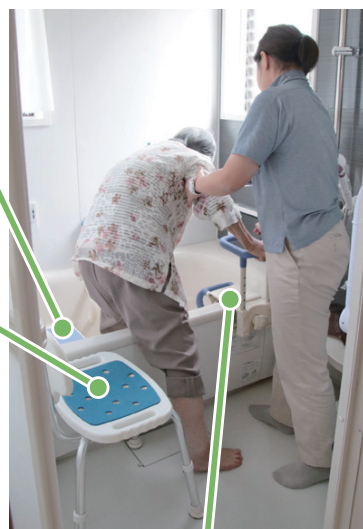
浴槽用手すり
